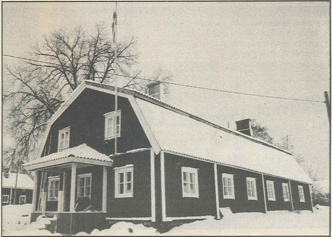
Ett av de gamla bostadshusen i Strömfors bruk. Huset är historiskt riktigt restaurerat och numera bebott.
